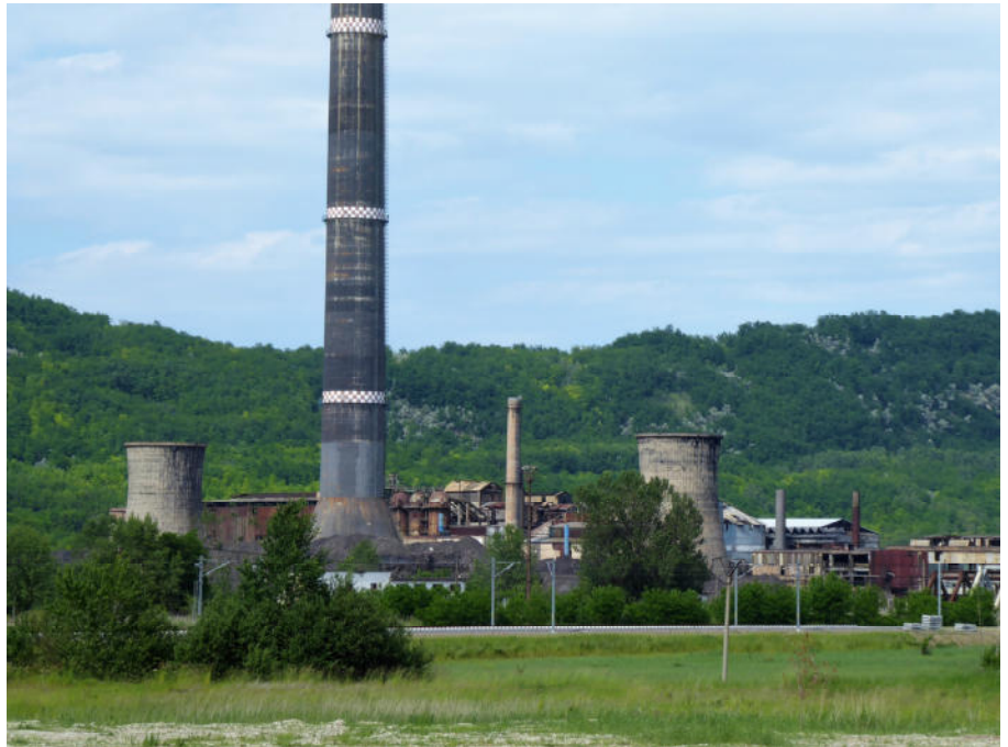
Aufgelassene Industriebetriebe aus kommunistischer Zeit zerfallen: Rußfabrik und Buntmetallhütte in Copşa Mică
